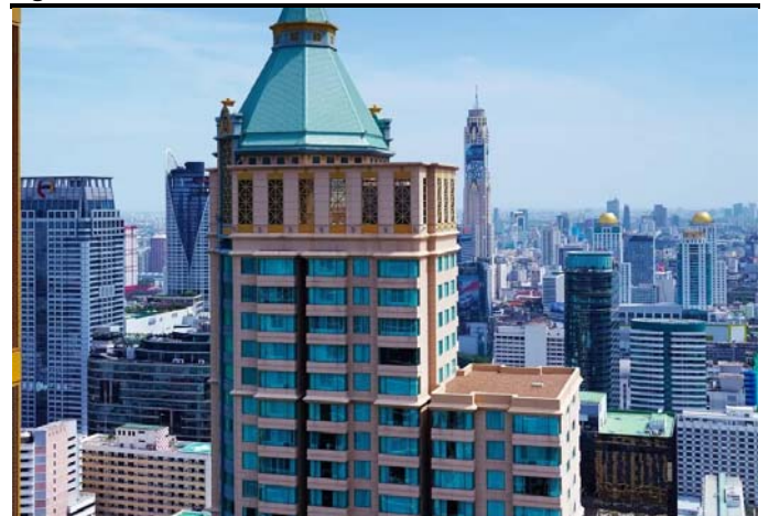
Figure 4: อาคาร GCPRD
